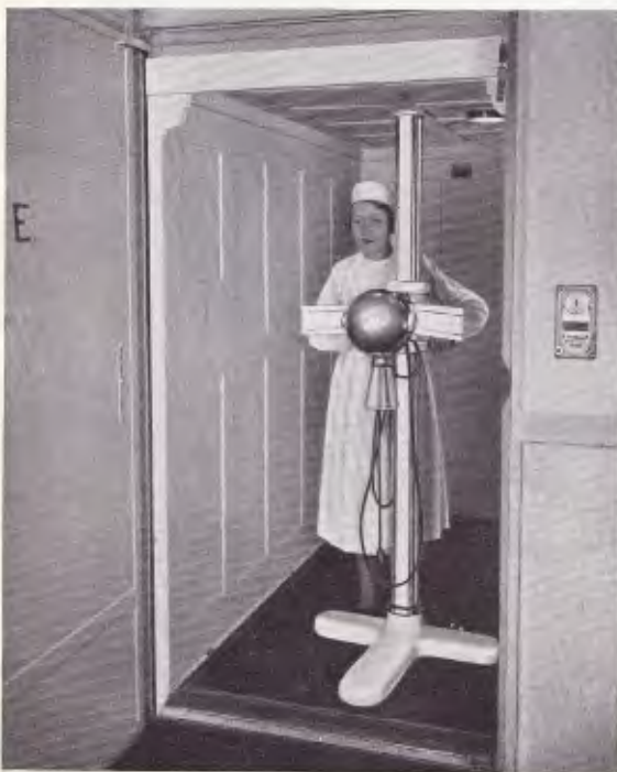
Bild 7. Die SIEMENS-RÖNTGENKUGEL kann mit dem nur 190 cm hohen „Standard“-Säulenstativ auch im Personen-Aufzug befördert werden
